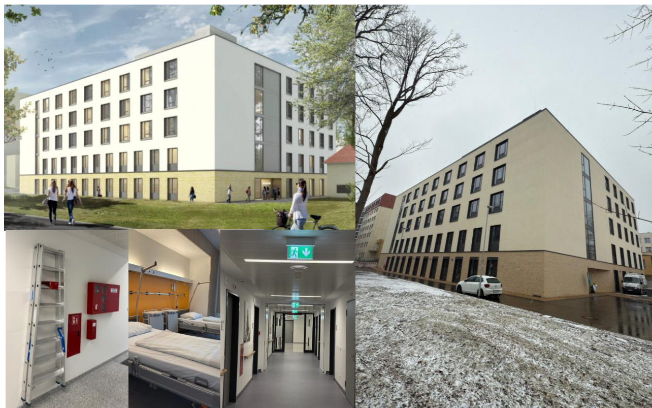
Neubau Innere Medizin und Geriatrie des Heinrich-Braun-Klinikum Zwickau – Zwickau / Sachsen (Quelle: https://www.sweco-gmbh.de/showroom/heinrich-braun-klinikum-zwickau/ ).
